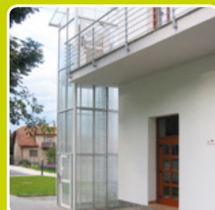
ZPS v presklenom ohradení dráhy
